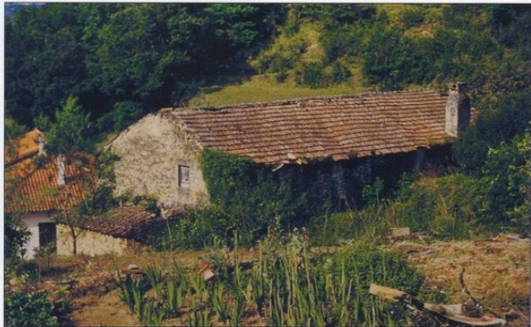
Fig. 82 Saint-Affrique (Aveyron). Le moulin du Juge -2-. Façade nord-est.
