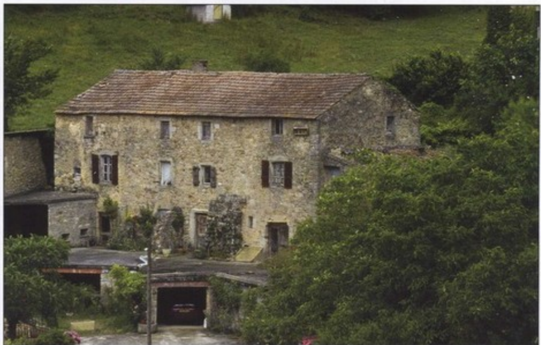
Fig. 83 Saint-Affrique (Aveyron). Le moulin du Juge -2-. Façade sud-ouest.
