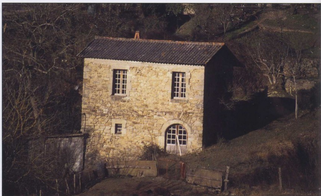
Fig. 84 Saint-Affrique (Aveyron). Le moulin du Juge -3. Façade sud-ouest.
