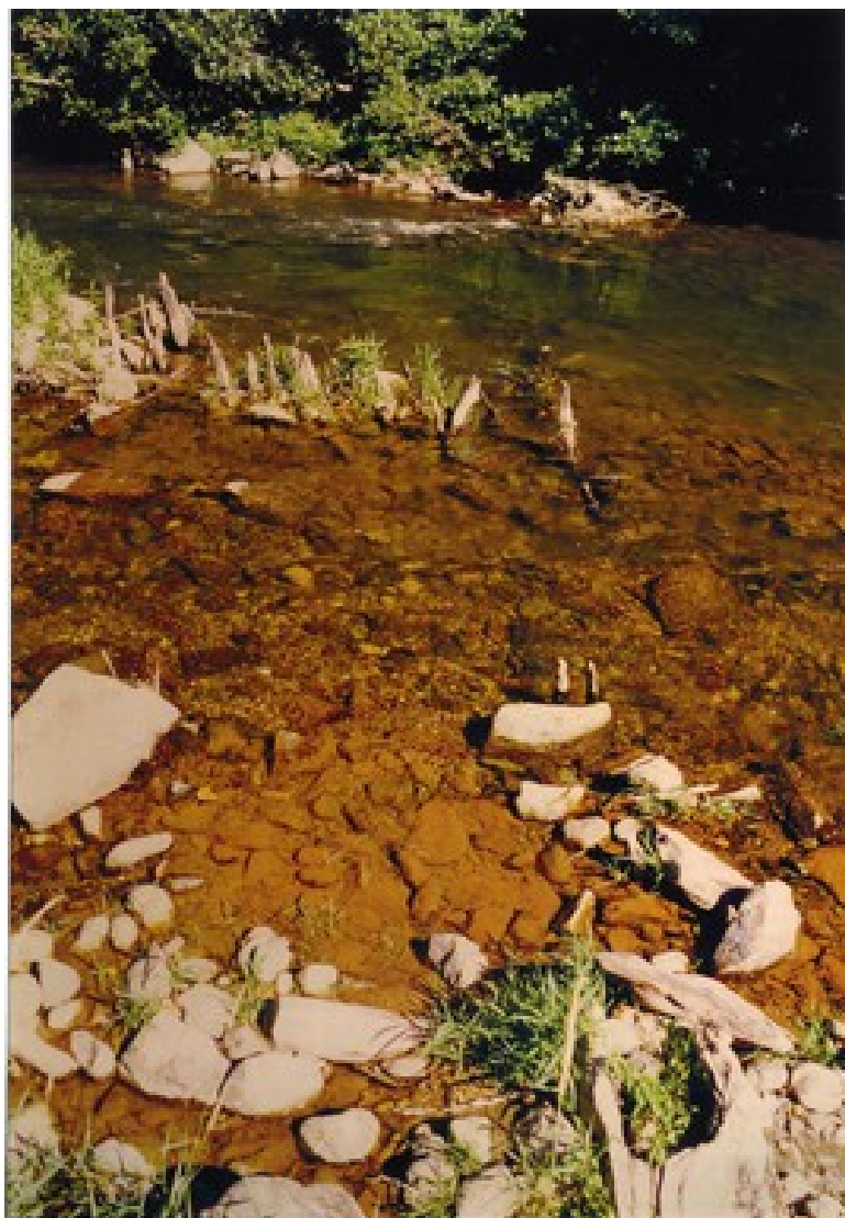
Fig. 338 Saint-Affrique (Aveyron). Moulin de Boumac. Fondations en bois de la chaussée au milieu du lit du Dourdou. © Photo JPH AZEMA, Juillet 2013.
