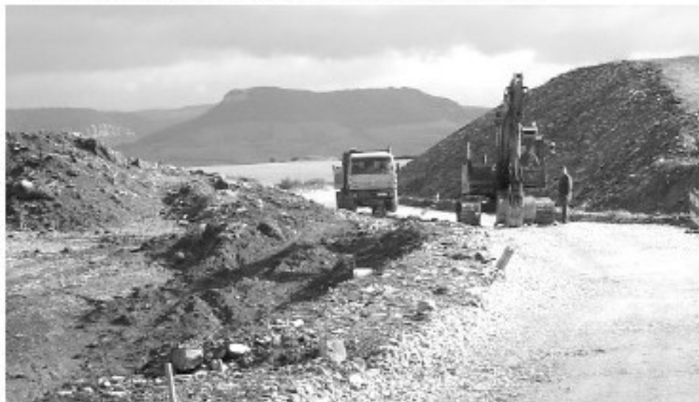
Un impressionnant chantier... et une vue magnifique.
