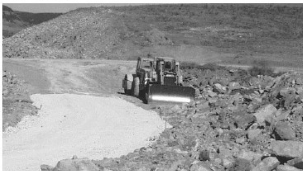
Des engins imposants pour des travaux importants.
