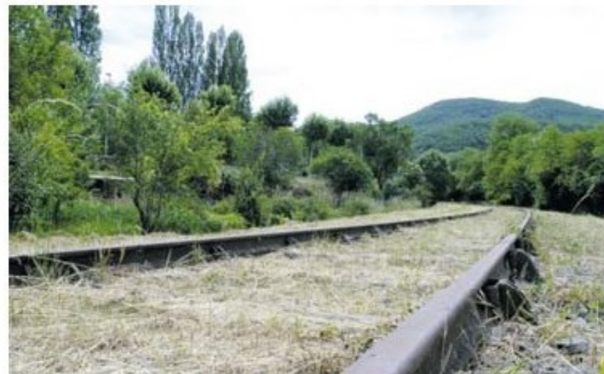
Les rails parallèles à la RD 7 vont laisser la place aux cyclistes.
