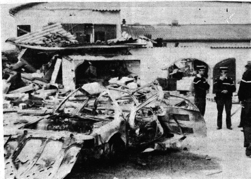
Au premier plan, la R 21 (ou ce qu'il en reste). L'entrée de la discothèque n'est plus que gravas enchevêtrés.
