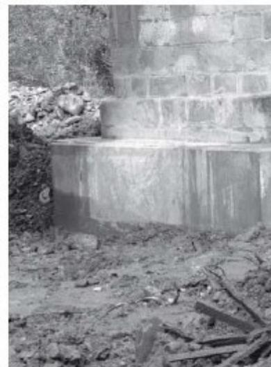
Les bases de chaque pile sont enfoncées à plus de 2 m de profondeur.
